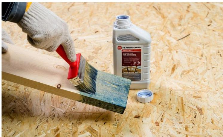
Рисунок 2. Процесс нанесения антисептика на поверхность древесины.
