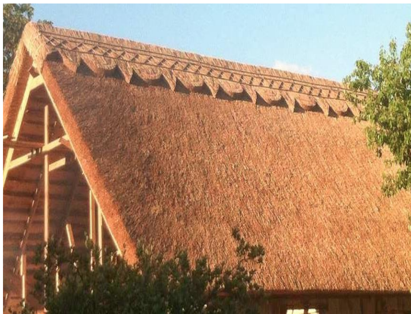
Рис.5. Камышовая (тростниковая) кровля
