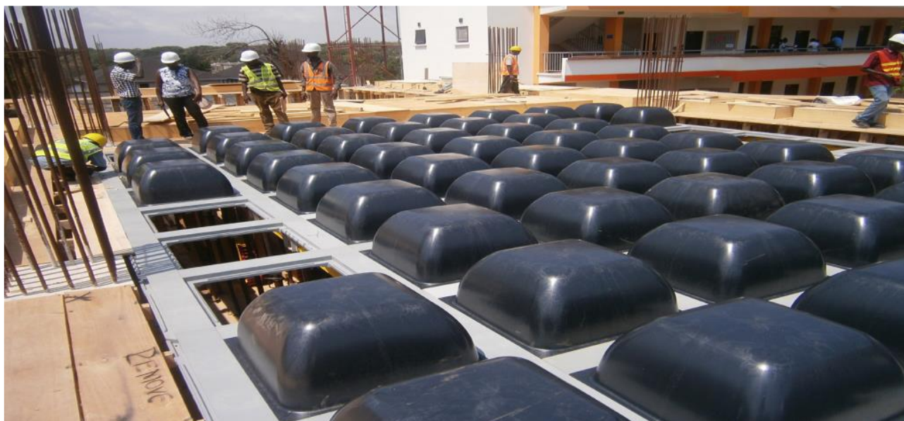
Рисунок 3. Кессонная опалубка типа «Skydome»
