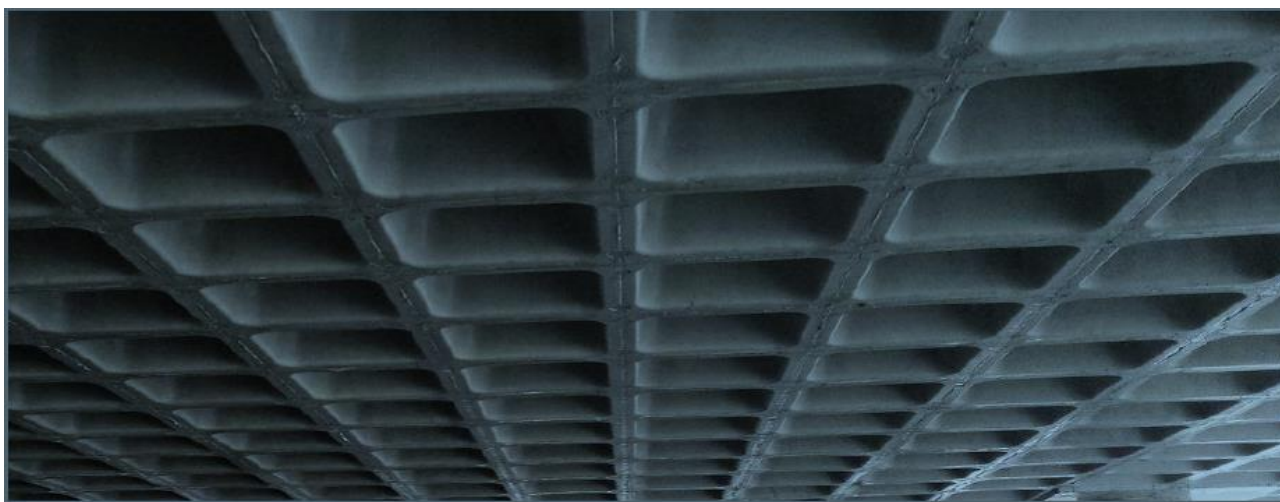
Рисунок 1. Внешний вид облегченного безбалочного перекрытия
