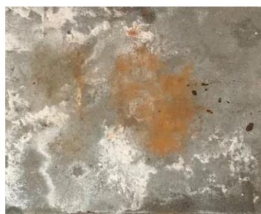
Рис. 6. Фотография исследуемой бетонной поверхности
